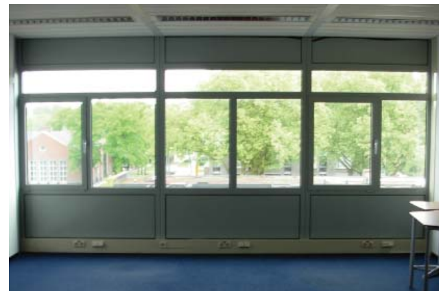
Fig. 42. Geveldeel aan de westkant van het gebouw (boven) en binnenaanzicht van de kozijnen (onder).
