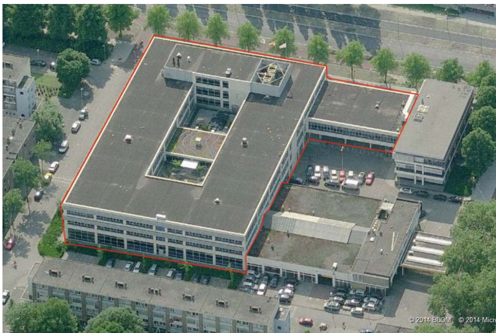
Fig. 40. Het deel binnen de rode lijnen wordt tijdens dit project behandeld. De regelmaat van de stramien en de uitzondering bij het trappenhuis is in de gevel goed zichtbaar. (bron: Bing Maps)
